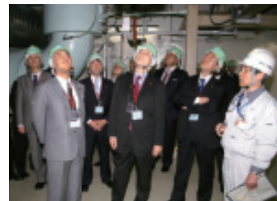
2次配管室の視察の様子
